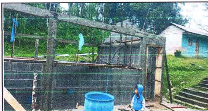
Foto 3: Retitando las maderas que sirvieron para fundir las columnas.
