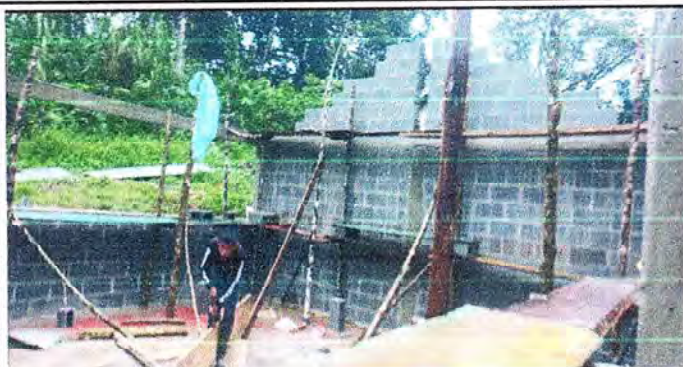
Foto1: Fundiendo las columnas del aula de remozamiento.
