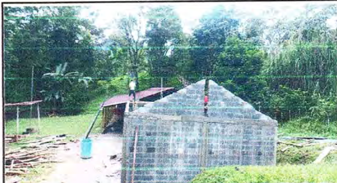
Foto2: Colocación de block del techo de dos aguas.
